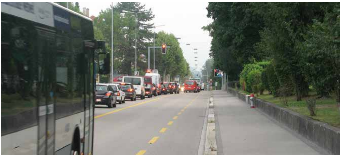
Albisstrasse: Busspur bei der Zufahrt dosierung am Stadtrand
